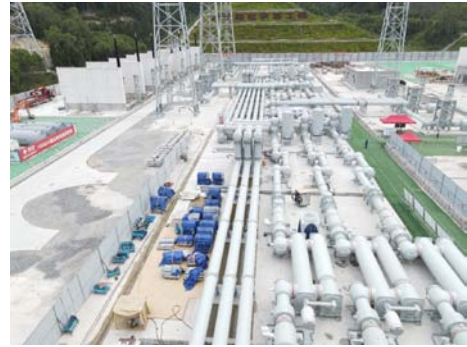
厦门长泰 1000 千伏变电站新建工程
