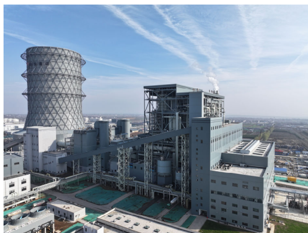
世界首台 660MW 高效超超临界循环流化床机组——陕西彬长项目
